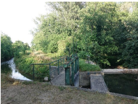
Abbildung 40. Wehranlage am Werkskanal (im Bild nach links fließend) in Günselsdorf ca. 100 m unterhalb der B17 bei Überleitung zur Triesting (im Bild rechts) (09.08.2024)
