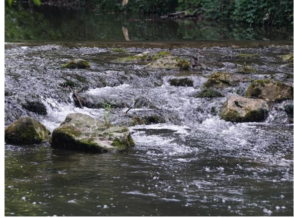
Abbildung 37. Eingeschränkt passierbare Sohlrampe in der Restwasserstrecke der Triesting stromab Ausleitung Werkskanal Günselsdorf - Tattendorf Höhe Flkm 21,60 (09.08.2024).
