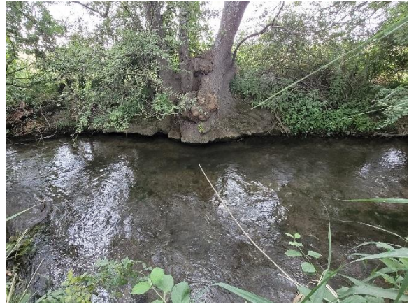
Abbildung 123. Kalter Gang stromab März- mühle, Fikm 16,1 (07.07.2024).
