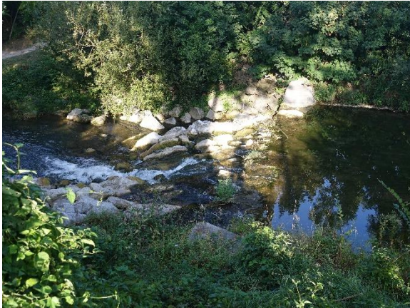
Abbildung 38. Nicht passierbare Sohlrampe in der Restwasserstrecke der Triesting in Günselsdorf Höhe Flkm 21,07 (09.08.2024)
