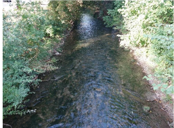
Abbildung 39. Werkskanal in Günselsdorf stromauf der Querung der B17, Blick stromauf (09.08.2024).
