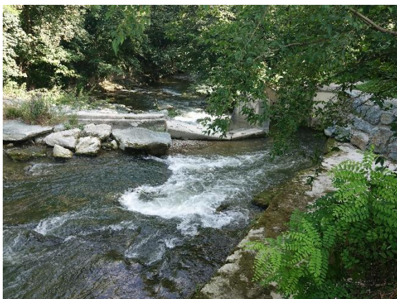
Abbildung 27. Ehemalige Wehranlage an der Triesting bei Flkm 23,23, Blick stromab; rechts Mauer aus Wasserbausteinen und davor Betonplatte: ehemalige Ausleitung (19.08.2024).
