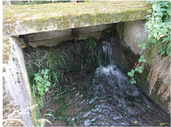
Abbildung 136. Ausleitung (Nebengerinne II) aus dem Kalten Gang Höhe Golfplatz Velm (09.07.2024). Abfluss ca. 5 L/s.
