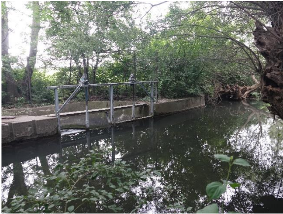
Abbildung 122. Kalter Gang, Ausleitung zur März- mühle, Fikm 17,0 (07.07.2024).
