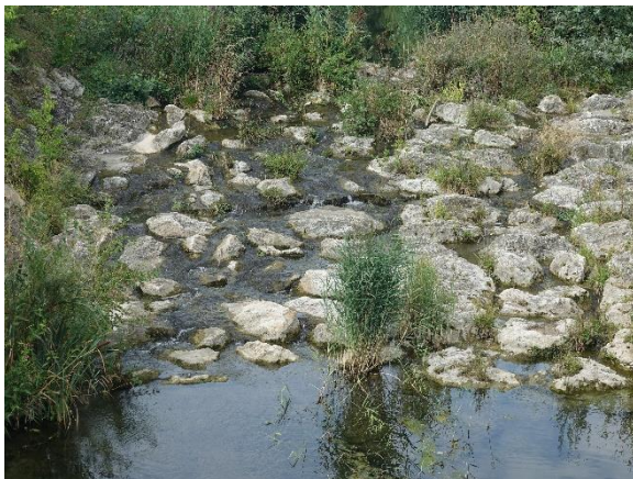
Abbildung 25. Sohlrampe in der Hochwasserentlastung Leobersdorf bei km 2,58, Abfluss ca. 30 L/s (19.08.2024)
