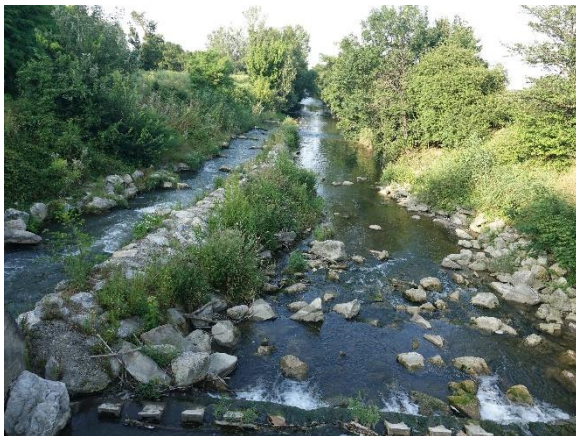
Abbildung 81. Triesting Flkm 8,27 mit FAH, über die nur ein Teil der Triesting fließt (18.07.2024).
