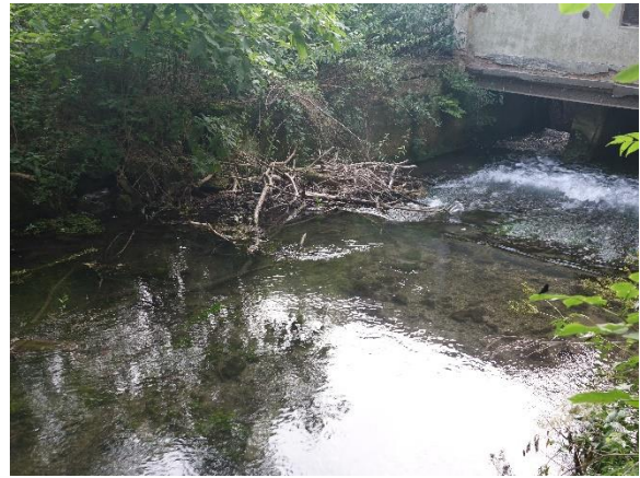
Abbildung 116. Kalter Gang ehem. Wehr der verfallenen Stangenmühle, Flkm 18,32 (09.07.2024).
