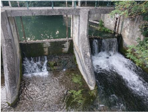
Abbildung 51. Triesting Oberwaltersdorf, Wehranlage Höhe Ausleitung zum KW Pfarrgasse, Flkm 15,16 (07.08.2024)
