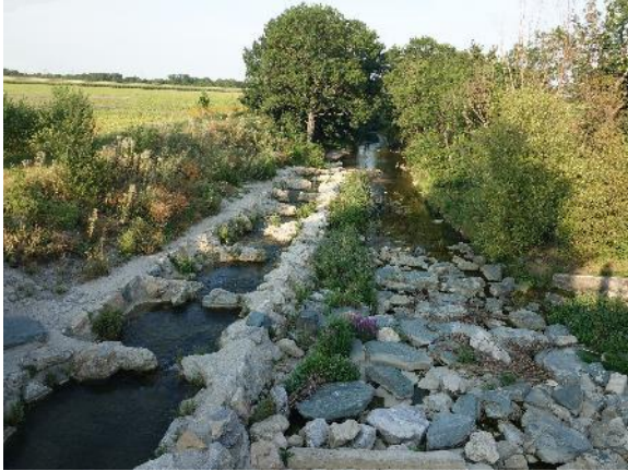
Abbildung 76. Triesting stromab Trumau Flkm 10,15. Der gesamte Abfluss fließt hier über die FAH (18.07.2024).
