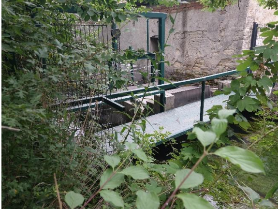
Abbildung 120. Kalter Gang, Ausleitung zur Rad- oder Donnermühle, Fikm 17,8 (07.07.2024).
