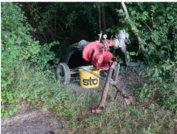
Abbildung 131. Bewässerungspumpe Höhe Einmündung Ausleitung (Nebengerinne VI) in den Kalten Gang Höhe Flkm 12,55 (07.07.2024).
