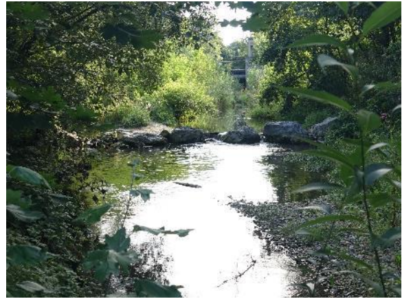
Abbildung 65. Triesting stromab Oberwaltersdorf, Restwasserstrecke nach Rotem Wehr, Flkm 12,6 (07.08.2024).
