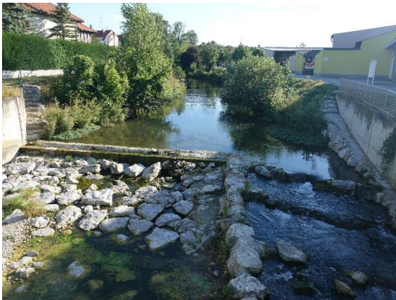
Abbildung 44. Sohlrampe in der Restwasserstrecke der Triesting in Teesdorf Höhe Flkm 19,39, Blick stromauf (09.08.2024)
