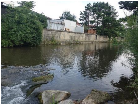
Abbildung 59. Triesting Oberwaltersdorf, Vollwasserstrecke Höhe Flkm 14,26 stromauf Sohlschwelle (07.08.2024)
