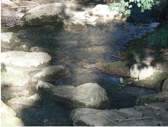
Abbildung 42. Überleitung vom Werkskanal zur Triesting (Einleitung Höhe Flkm 20,8), Abfluss durch Wehrundichtheiten ca. 10 L/s (09.08.2024)
