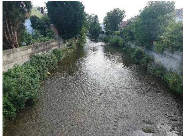
Abbildung 60. Triesting Oberwaltersdorf, Vollwasserstrecke Höhe Flkm 14,00 stromab Fußgängerbrücke (07.08.2024).
