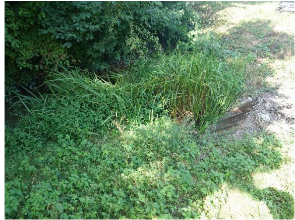
Abbildung 31. Einlauf der Zuleitung vom Schönauer Teich Höhe km 1,24, danach trocken (19.08.2024).
