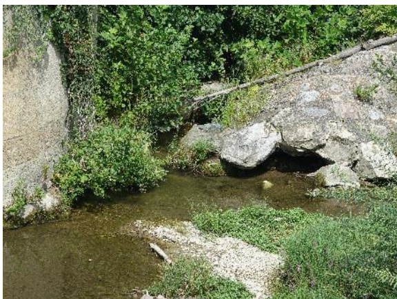
Abbildung 68. Einstieg FAH unterhalb Rotes Wehr, Dotation am 19.08.2024 ca. 20 L/s.
