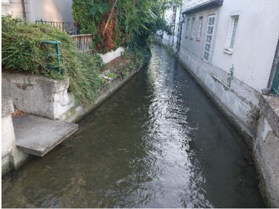
Abbildung 70. Werkskanal Trumau (Ausleitung Rotes Wehr) Höhe Raiffeisenstraße (18.07.2024).
