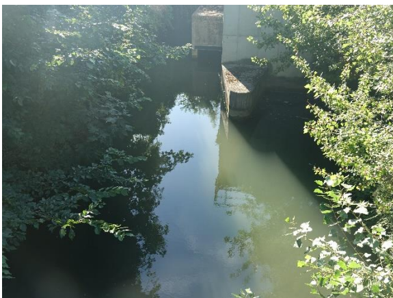
Abbildung 46. Werkskanal stromab Teesdorf direkt vor dem KW Mühlhofstraße Höhe Triesting-Flkm 18,6 (09.08.2024)
