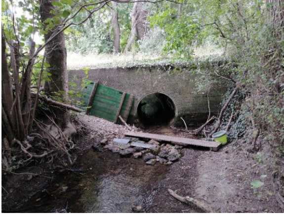
Abbildung 177. Mögliche Absperreinrichtung an einem Nebengewässer des Kalten Gangs stromauf Golfplatz Velm.
