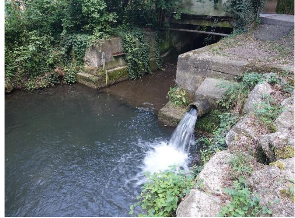
Abbildung 141. Ausleitung aus dem Kalten Gang Höhe Flkm 8,815 Richtung Neubach (PS. BL-2758, ca. 10 L/s; 09.07.2024).
