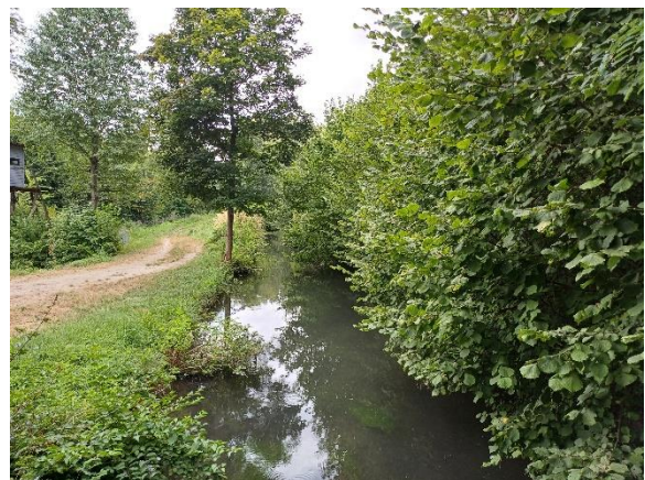
Abbildung 138. Kalten Gang nördlich Velm. Die Lage über dem Gelände verursacht vermutlich merkliche Versickerungen (01.08.2024, vgl. Anhang II).
