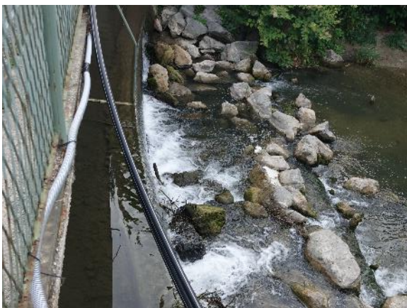
Abbildung 55. Triesting Oberwaltersdorf Flkm 14,7, Wehranlage (07.08.2024)
