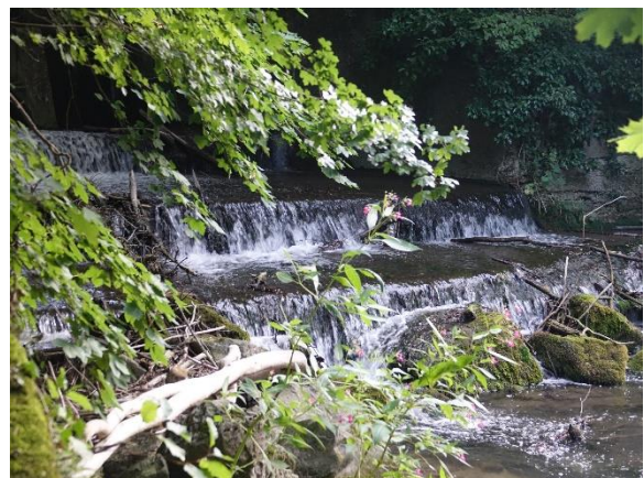
Abbildung 35. Rechtsufrige Überleitung vom Stau der Wehranlage Flkm 21,84 in die Triesting ca. 50 m stromab der Wehranlage. Abfluss ca. 100-200 L/s (09.08.2024).
