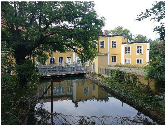
Abbildung 53. Triesting Oberwaltersdorf, KW Pfarrgasse etwa Höhe Flkm 14,7 (07.08.2024)
