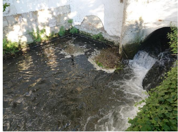
Abbildung 148. Nicht passierbares Querbauwerk am Kalten Gang bei der ehem. Mühle in Zwölfaxing, Flkm 4,74.
