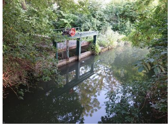
Abbildung 71. Staubereich Werkskanal Trumau und Ausleitung Feierbach (18.07.2024).
