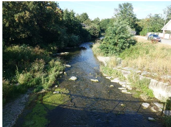
Abbildung 45. Restwasserstrecke der Triesting in Teesdorf stromab Rampe Höhe Flkm 19,39, Blick stromab (09.08.2024).
