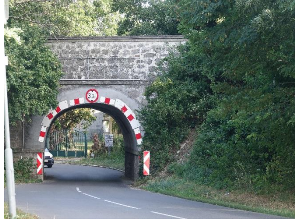
Abbildung 43. Querung des Werkskanals in Teesdorf als Aquädukt bei der Badenerstraße, Werkskanal-Flkm 0,28 (09.08.2024).
