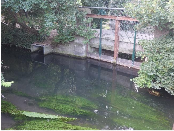
Abbildung 140. Kalter Gang in Himberg, Flkm 8,815 (09.07.2024). Ausleitung Richtung Neubach (PZ. BL-2758, ca. 10 L/s).
