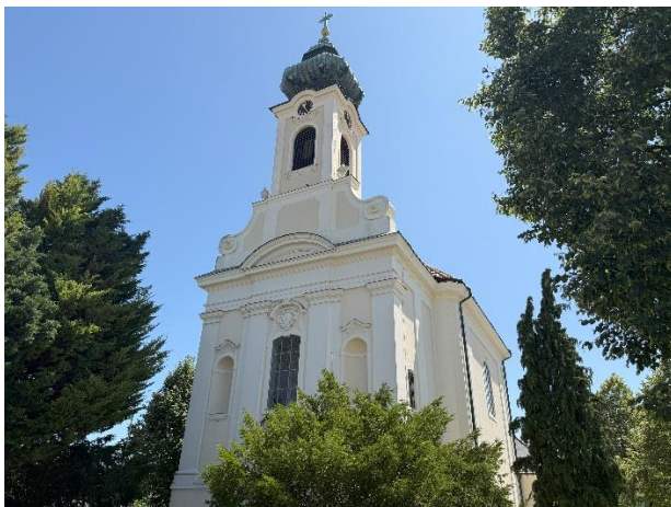
Abbildung 3: Kath. Pfarrkirche hl. Leonhard (Quelle: eigene Aufnahme)
