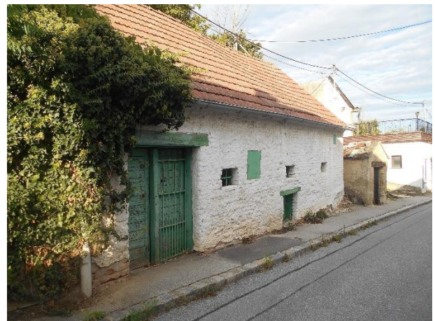
Abbildung 13: Kellergasse „Obere Berggasse“
