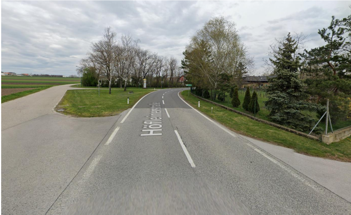
Abbildung 11: Anfahrsichtweite L164 km 7,4. Blickrichtung Scharndorf: ca. 55 - 66m (Quelle: Google Street View, April 2023)
