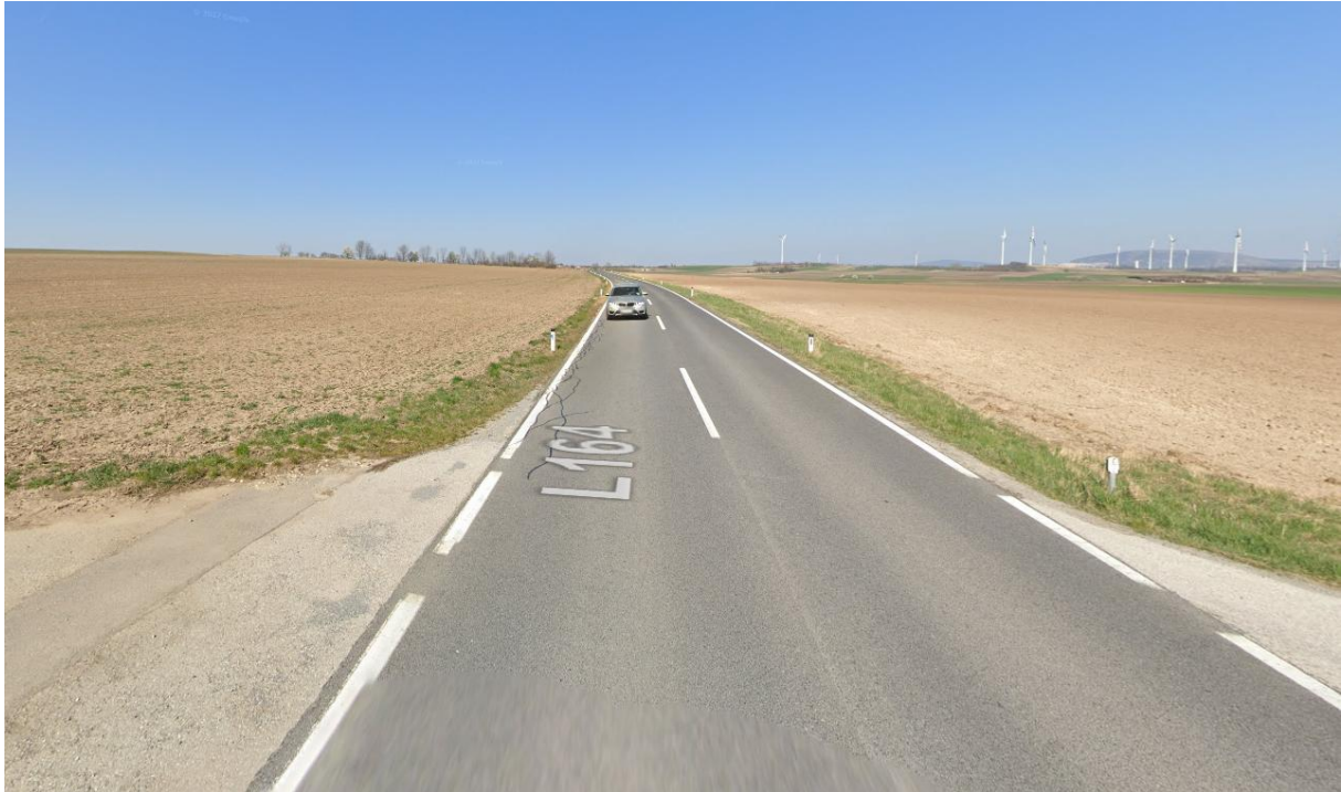
Abbildung 9: Anfahrsichtweite L164 km 6. Blickrichtung Scharndorf: ca. 330 - 370m (Quelle: Google Street View, März 2022)
