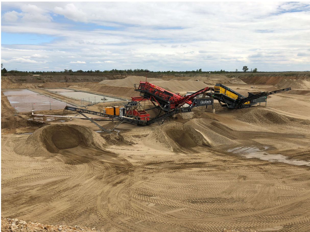
Abbildung 2: mobile Kieselauflbereitungsanlage, dahinter die Absetzbecken für das Waschwasser für den genehmigten Kieselabbau auf Allbau I und Allbau II.
