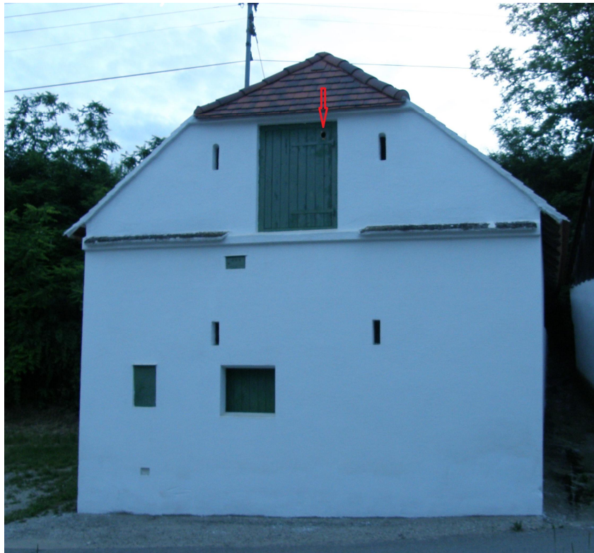
Abbildung 10: Renovierter Keller in Hadres, bei dem ein Einflugloch (roter Pfeil) in einen Nistkasten führt
