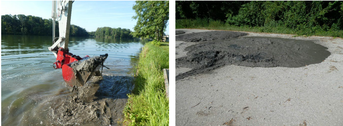
Abbildung 12: Sedimententnahme im Uferbereich mit dem Bagger (links) und abgeladenes naturnasses Sediment (rechts)
