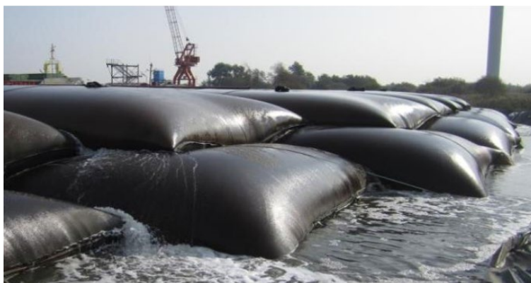
Abbildung 22: Aus den Entwässerungsschläuchen ausfließendes Wasser (Huesker Synthetic GmbH 2020)
