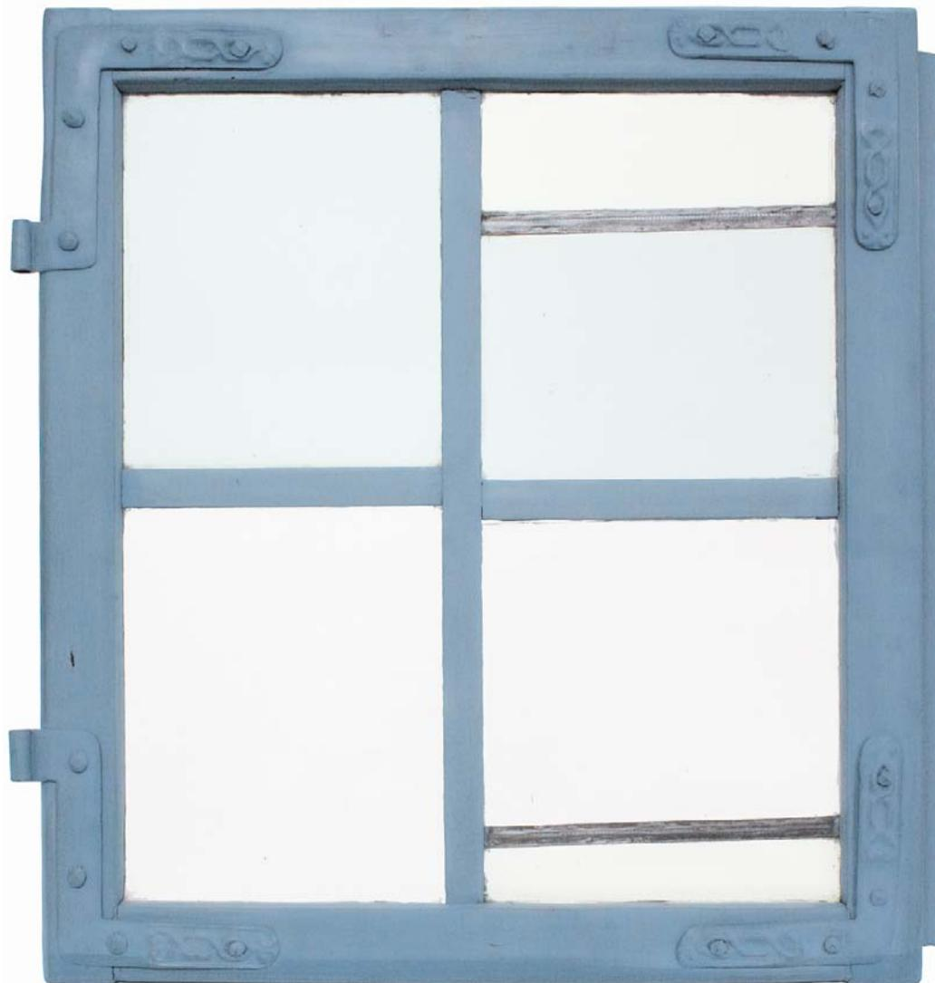
Glasscheiben nicht mehr genutzt, sondern erhielten an der Außenseite einen Kittfalz. Die Scheiben fixierte man im Falz mittels Glaserstiften und festigte sie anschließend mit Leinölkitt.
