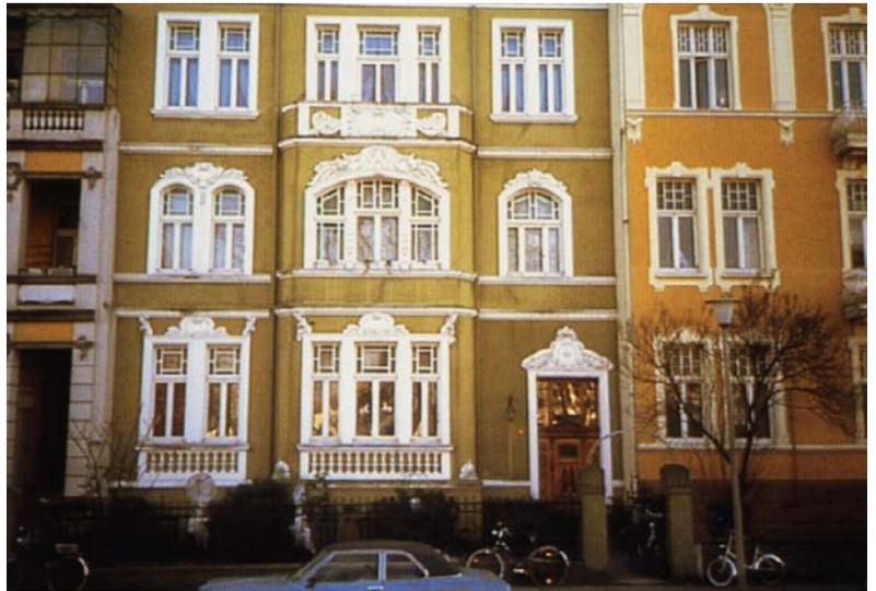
Metall- oder Kunststoffenster ausgetauscht, wie sie vom Baustoffhandel landauf landab angeboten werden. Die in kälteren Gebieten unseres Landes seit Jahrzehnten üblichen hölzernen Kastendoppelfenster werden durch großflächige Kippflügelkonstruktionen ersetzt. Deren Rahmenprofile müssen aus statischen Gründen verstärkt werden, wodurch sie notwendigerweise viel größer wirken als
