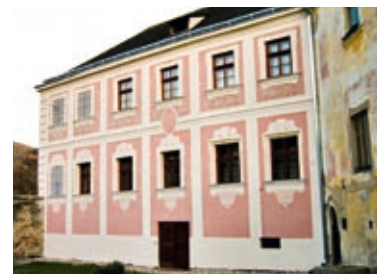
Spitz, Pfarrhof, die restaurierte Hoffassade
