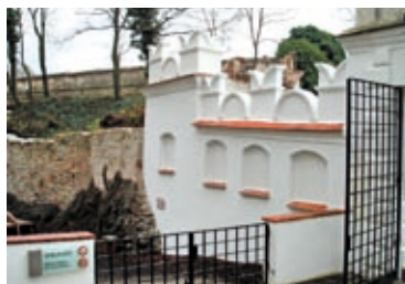
Rehgraben, nach Restaurierung
