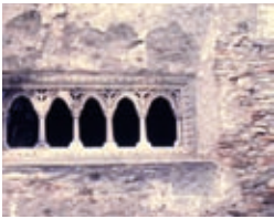
Margarethen am Moos, Karner, 13. Jh., Verputz mit Quadermalerei über Bruchstein
