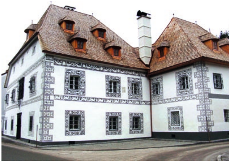
Lunz am See, Amonhaus, nach Restaurierung
