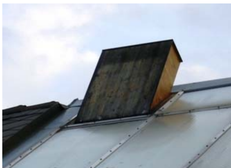
Abbildung 8: Abzugskanal für Überhitze > 80^\circ\text{C} )
