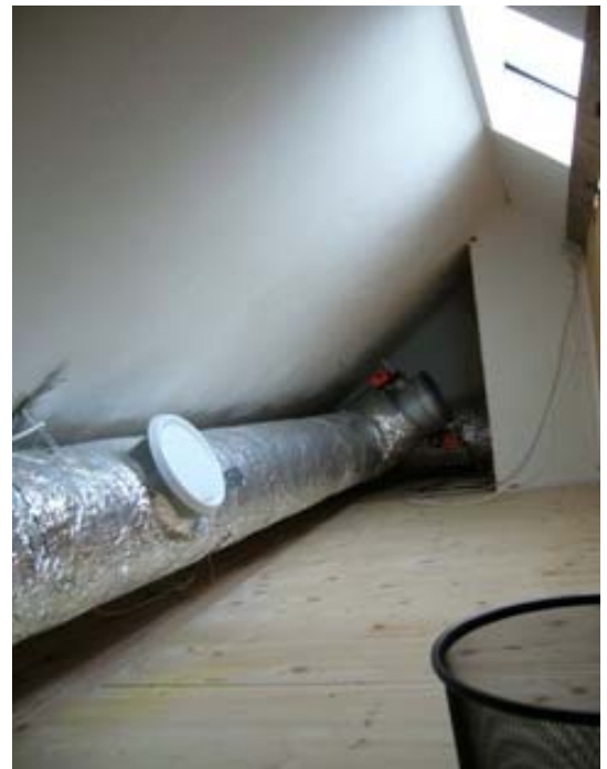
Abbildung 18: By-Pass zur Luftführung im Sommer: links frei im Giebel von unten, rechts in der Dachkammer
