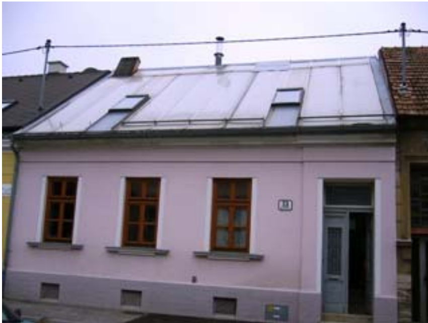
Abbildung 2: Luftsolaranlage, ins Hausdach integriert
