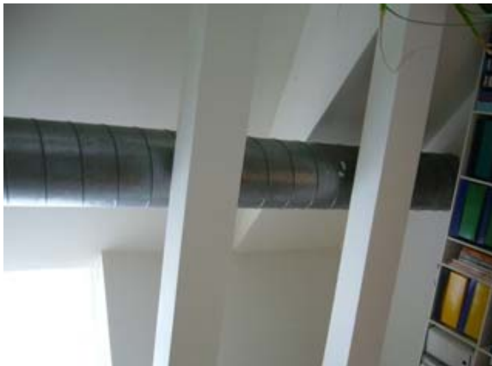
Abbildung 18: By-Pass zur Luftführung im Sommer: links frei im Giebel von unten, rechts in der Dachkammer
