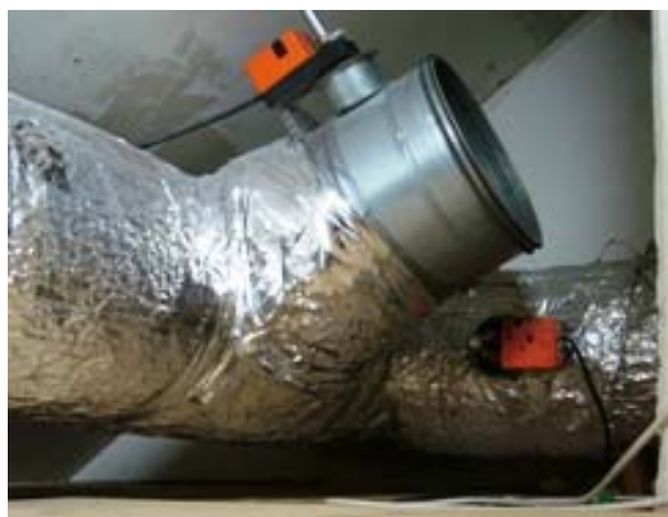
Abbildung 20: Klappe zur Absaugung der warmen Luft aus dem Hausinneren - zur Gebäudekühlung.
