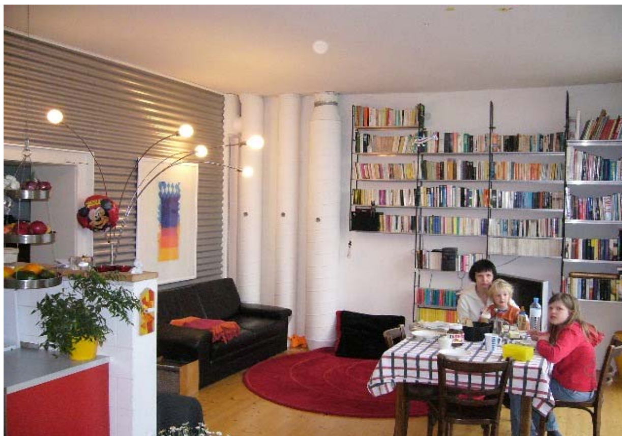
Abbildung 15: Wohnsituation mit integrierten Komponenten der Luft-Heizanlage: links die Heizwand, an der Rückwand die Luftrohre - 2 links für Heizanlage. 1 rechts für Speicherbefüllung
