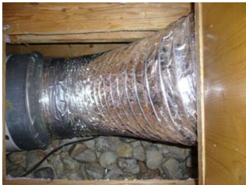
Abbildung 12: Vorlaufverdichter des Steinspeichers von oben
