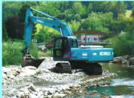
Bauliche Maßnahmen zur Risikominimierung im Hochwasserfall
