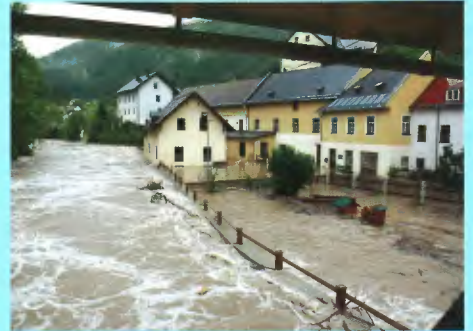
Ybbs in der Marktgemeinde Lunz am See, Hochwasser 2007
