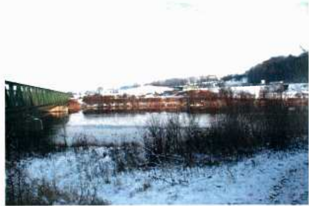
Ansicht des Betriebsgebietes von Südwesten
