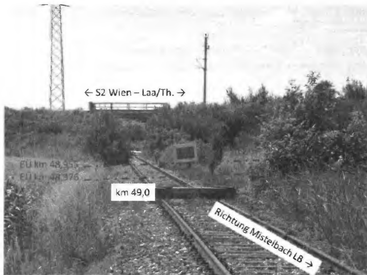
Blickrichtung Ernstbrunn im Hintergrund Unterquerung der ÖBB-Bahnlinie S2 hinter der S2-Brücke befindet sich rechts die provisorische Haltestelle „Mistelbach Interspar“ in ca. km 48,82 (Bahnsteigschüttung sichtbar); im Vordergrund provisorischer Gleisabschluss in km 49,0 (Eigentumsgrenze ÖBB/NÖVOG)
