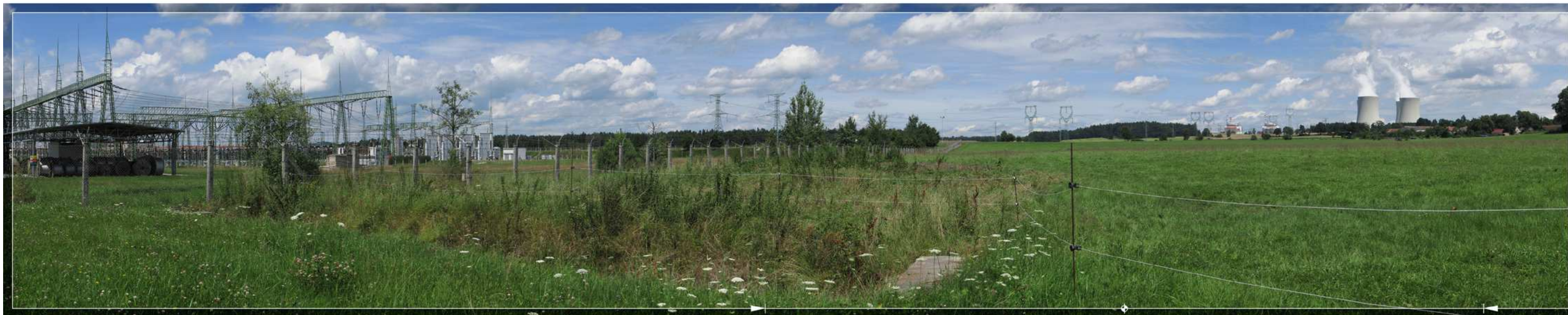
Bild 11.02: Blick vom östlichen Rand des Umspannwerkes Kočín aus in Richtung KKW Temelín (Blick von S aus einer Entfernung von 300–2 400 m)
