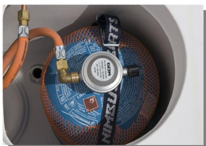
gasdichter Behälterschrank mit Entwässerung an tiefster Stelle
