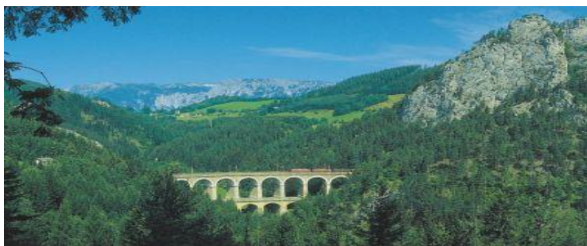
Bild 5 Semmeringbahn (Viadukt über die „Kalte Rinne“)
