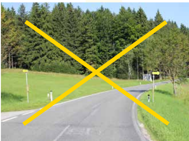
Haltestellen mit fehlender Auftrittsfläche entsprechen nicht dem Stand der Technik.
