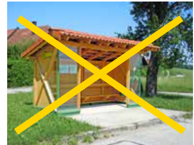
Die Auftrittsfläche ist nicht barrierefrei erreichbar.
