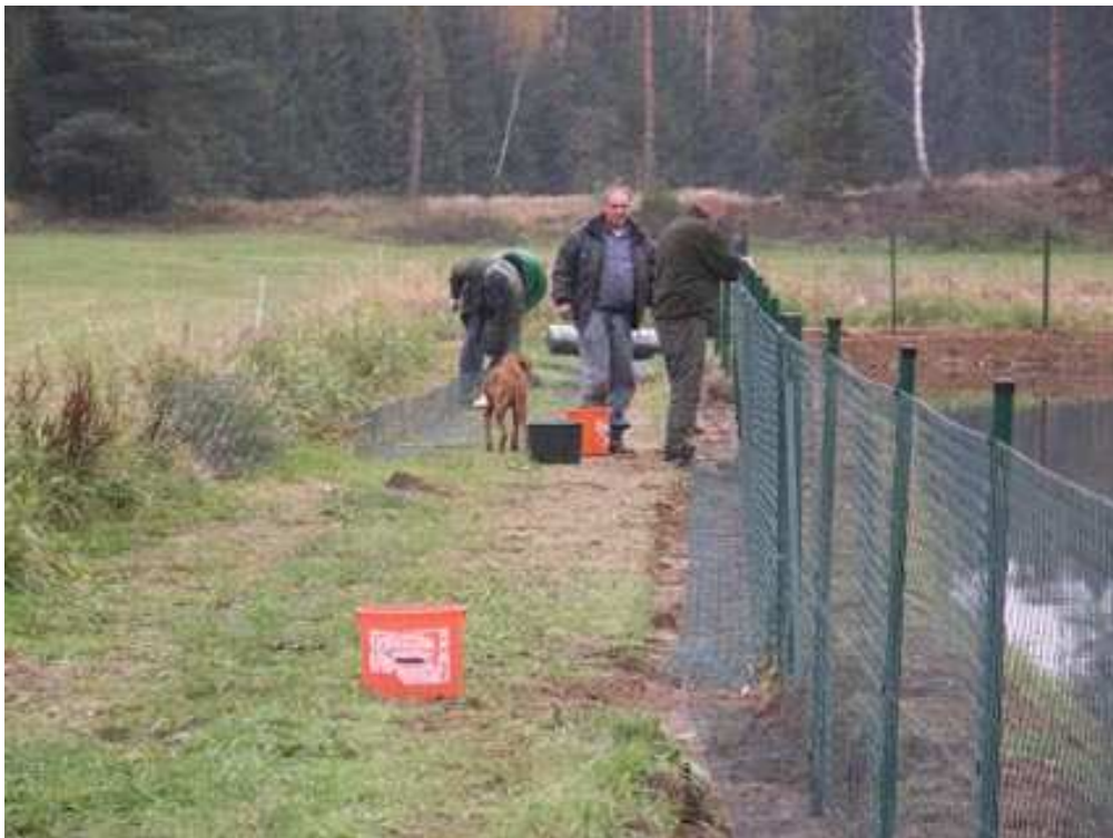
Abb. 2: Das Einbinden in die Spannsäulen und spannen des Zaunes ist eine große Herausforderung und erfordert gewissenhafte Arbeit.
