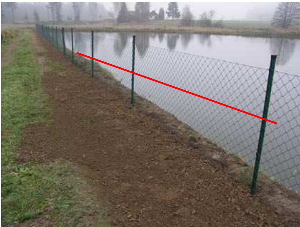
Abb. 6: Als Abschluss wird der Fixzaun auf der Außenseite etwa im Bereich der Zaunmitte bzw. knapp unter der Zaunmitte (auf einer Höhe von ca. 40-60 cm) noch mit einer nahe am Zaun befindlichen Elektrolitze umspannt (siehe rote Linie) um eine zusätzliche Absicherung gegen ein überklettern zu bieten.
