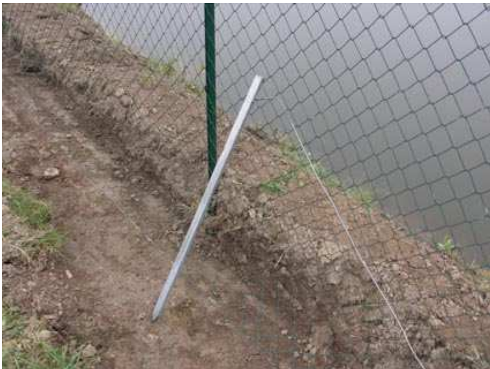
Abb. 4: Vor dem Einschottern wurden die Erdung und der Anschluss für die Elektrolitzen gleich mitverlegt mit 3 Erdungsstäben im Abstand von ca. 3 m. Empfohlen wird die Verwendung von mind. 2, besser 3 Erdungsstäben im Abstand von 3 m (Auf gute Erdung achten: Je besser die Erdung, desto mehr Spannungsübertragung auf die Stromlitze!).
