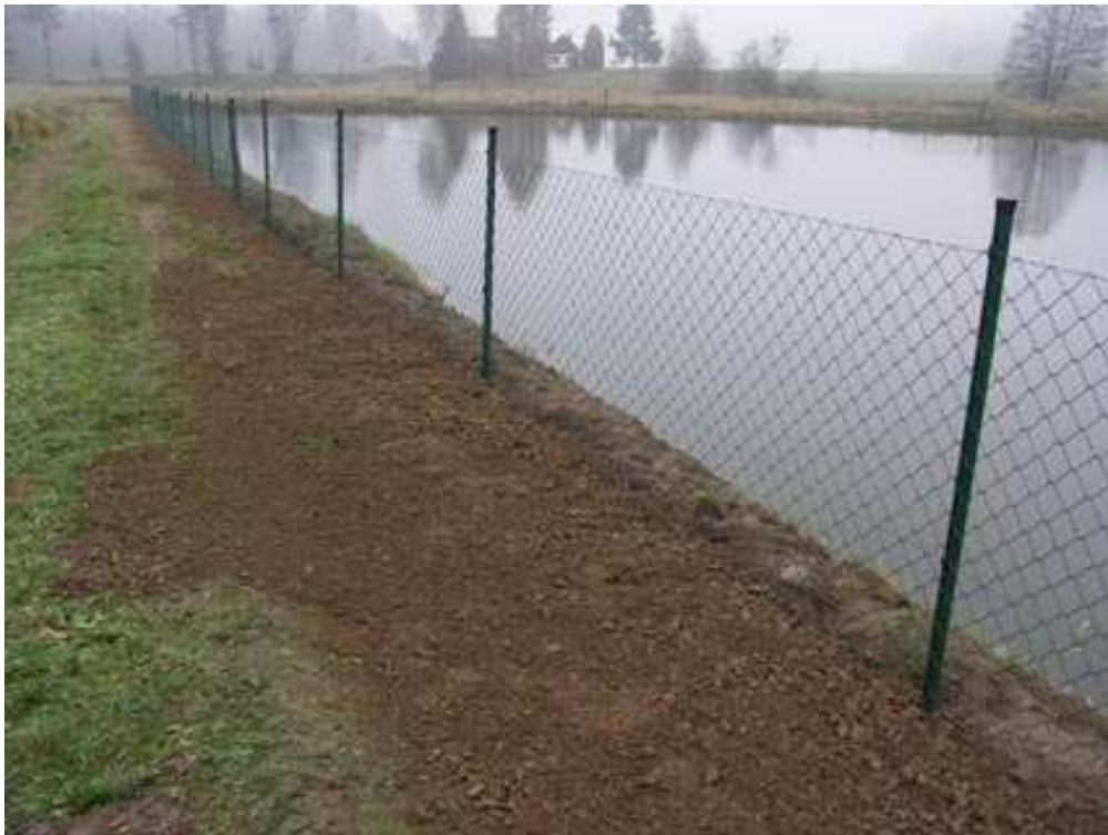
Abb. 3: Fertig eingeschotterter Zaun auf der Außenseite.
