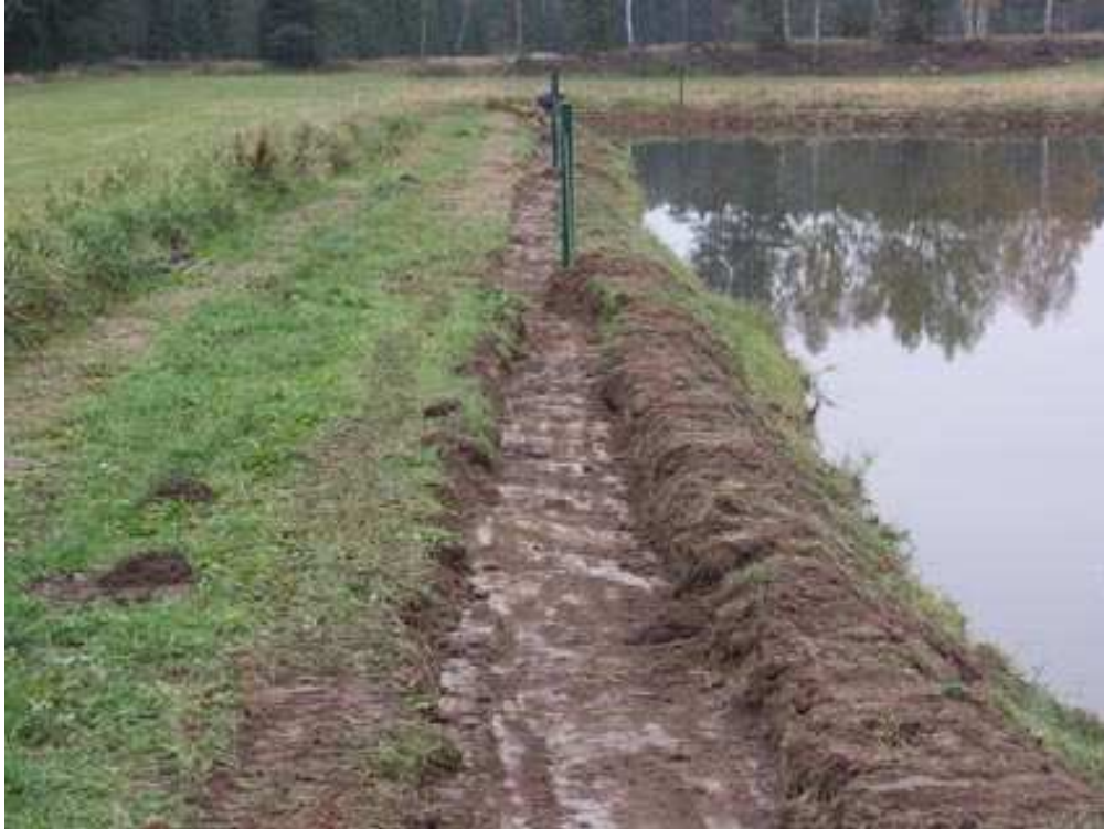
Abb. 1: Mit einem Minibagger wurde eine ca. 40-50 cm breite und bis zu 10 cm tiefe Künette ausgegraben um einerseits die Sohle möglichst zu begradigen und bessere Aufstellbedingungen für einen punktgeschweißten Maschendrahtzaun zu schaffen und um die umgeknickten Zaunfelder besser einschottern zu können.
