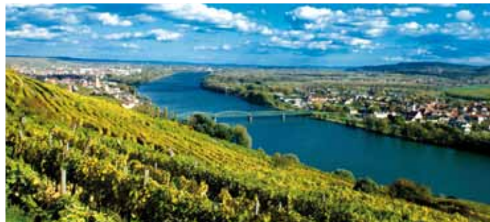
Donaubrücke zwischen Stein und Mautern
