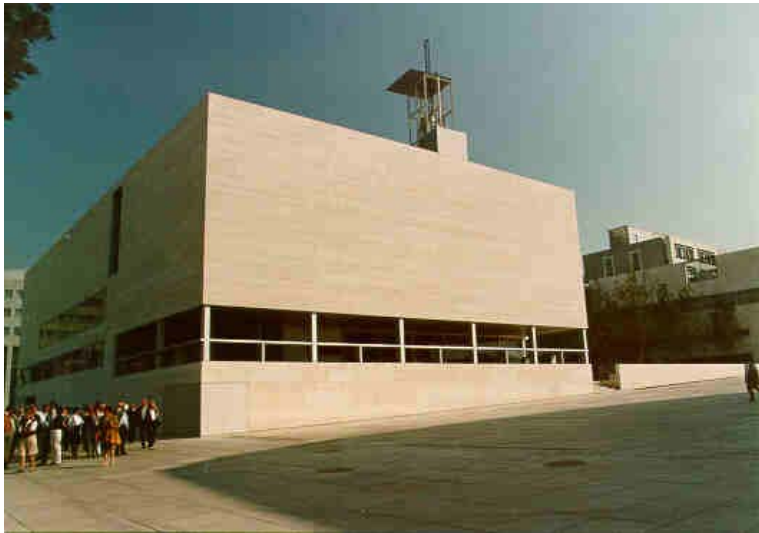
Außenansicht West, © Ing. Alfred Pohl, St. Pölten
