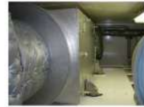
Partikelfilter im Motorraum
