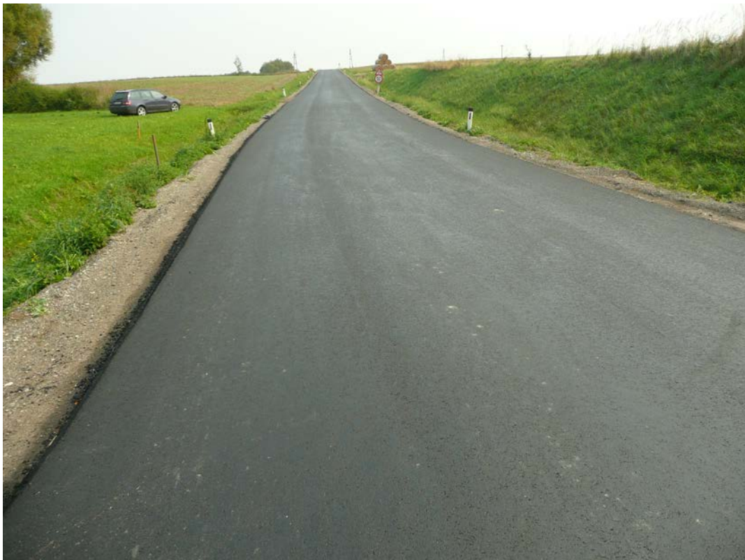
Straßenzustand der L 52 nach der Sanierung:
