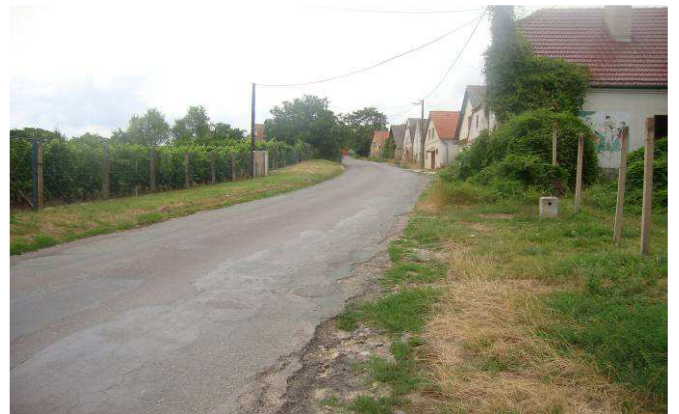
Zustand vor der Rekonstruktion
