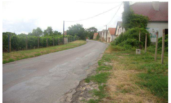
Zustand vor der Rekonstruktion
