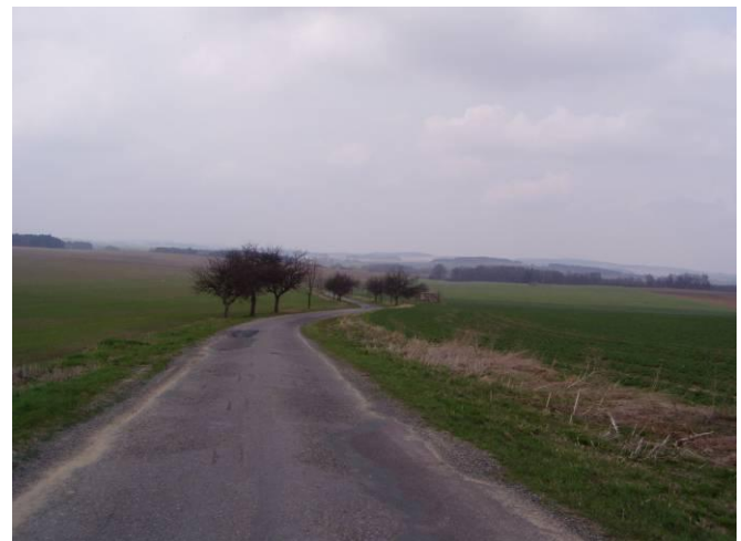
Zustand vor der Rekonstruktion
