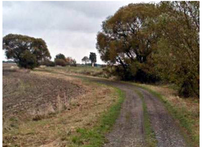
Zustand vor der Rekonstruktion
