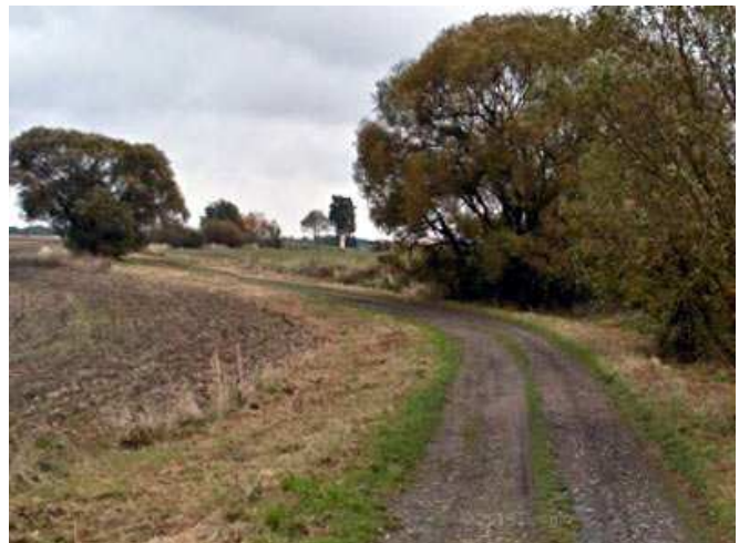
Zustand vor der Rekonstruktion
