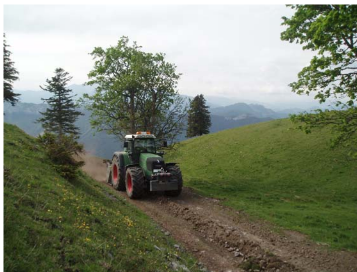
Bild 6: Eine Wegebaufräse im Einsatz
