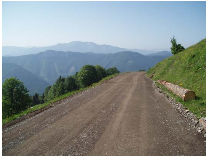
Bild 9: Fertiger Weg mit Querentwässerung
