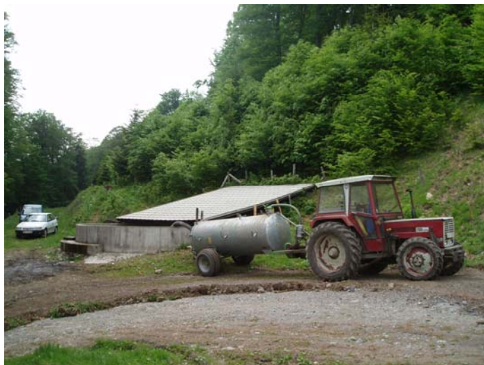
Bild 7: Wasserzugabe zur optimalen Verdichtung
